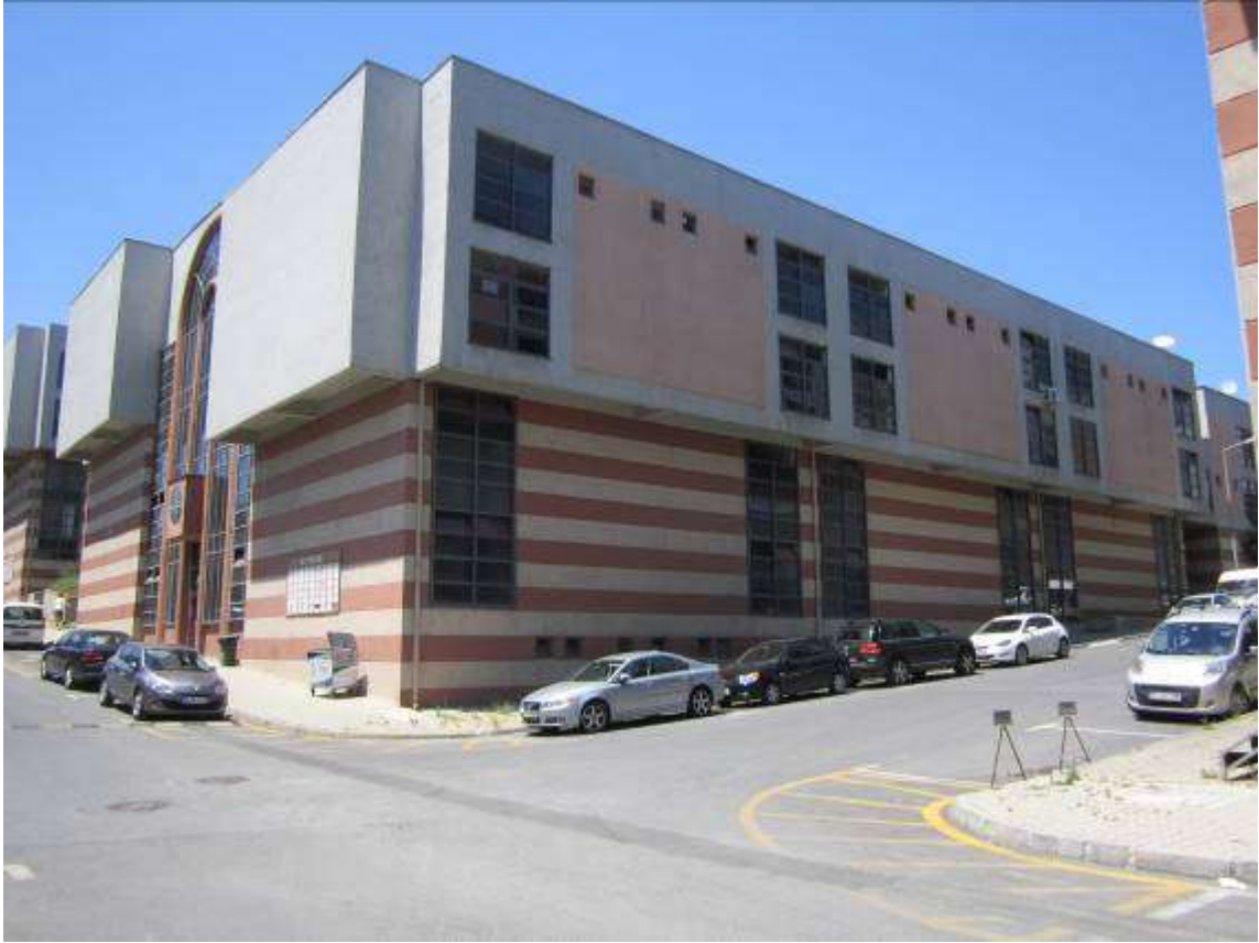
Taşınmazın yer aldığı A-3 Blokun Görünümleri
